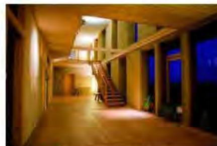
Lehmpassivhaus in Tattendorf mit gestrichener Lehmoberfläche
